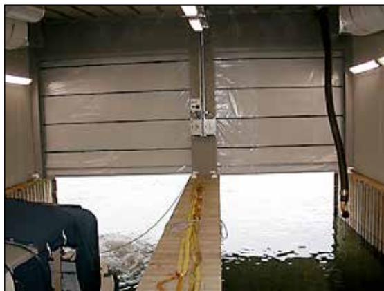
B9 monterad i Volvo Pentas testanläggning. Vid stängt läge är portarna ca 0,5 m under vattnet.
