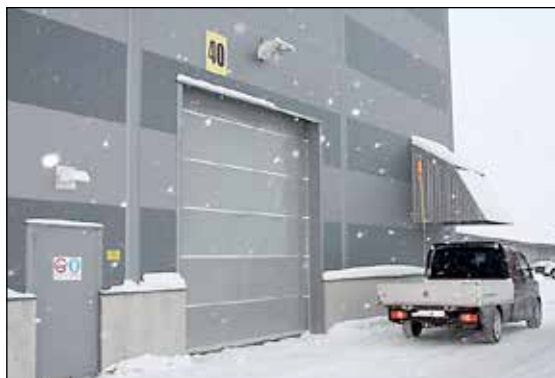
B9 monterad i Bolidens Aitikgruva.
