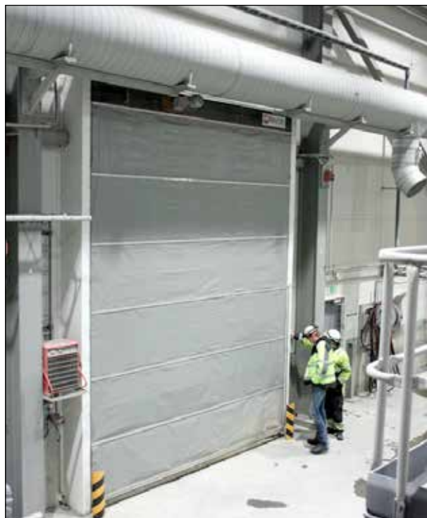
B9 monterad i Bolidens Aitikgruva.
