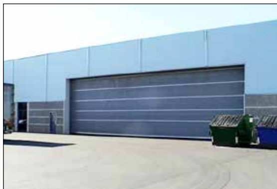
En B16 monterad hos CCB (Coast Center Base) utanför Bergen i Norge.
