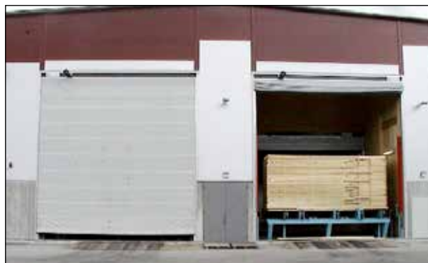
Två st B16 monterade hos SCA i Sundsvall.
