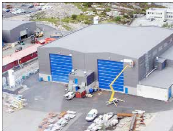
Två st B16 monterade hos CCB (Coast Center Base) utanför Bergen i Norge
