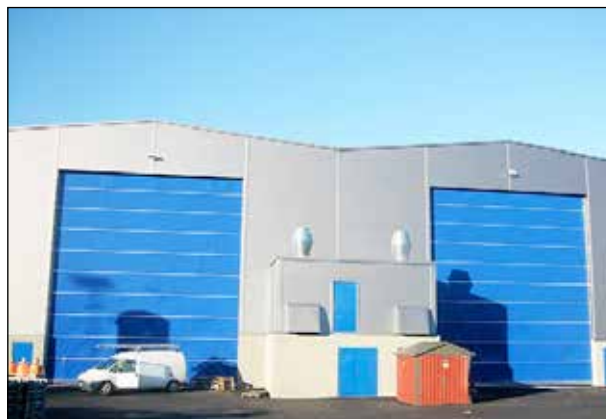
Två st B16 monterade hos CCB (Coast Center Base) utanför Bergen i Norge.
